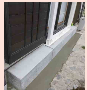
4 フレーム基礎・取付完了
