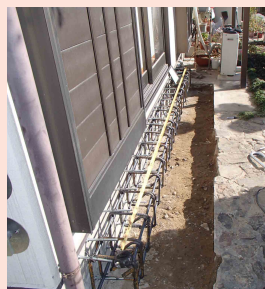
2 アンカー打設配筋完了
