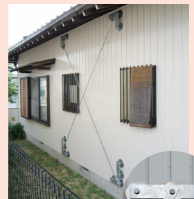
4 ブレース取付け工事完了
