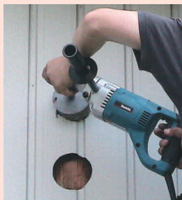
1 外壁くり抜き
