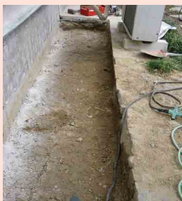
1 掘削・目荒し完了
